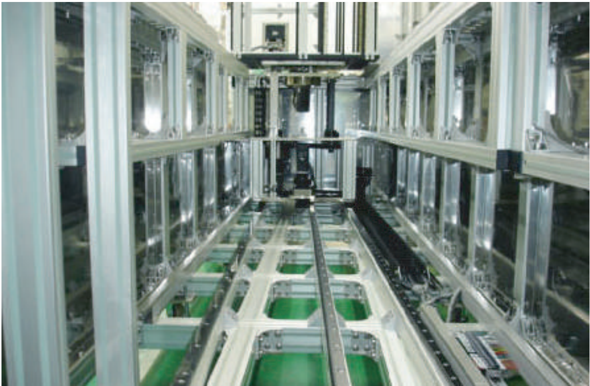
物流線型鋁鋼骨結構
